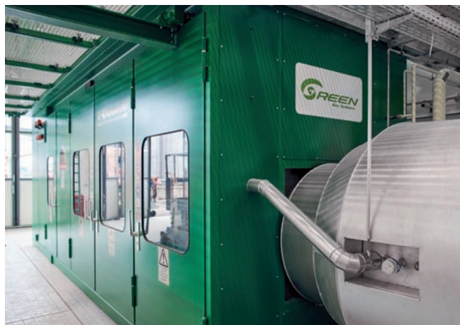
Plynová turbína sa využíva na výrobu elektrickej energie, pary a horúcej vody. (© by Endress+Hauser)
