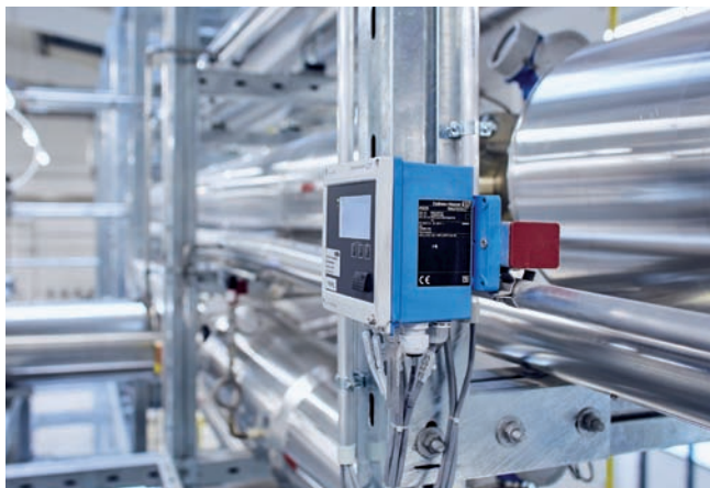
Kalorimetrické počítadlo na meranie pary EngyCal RS33 zaznamenáva hmotnosť pary a energetický prietok. (© by Endress+Hauser)
