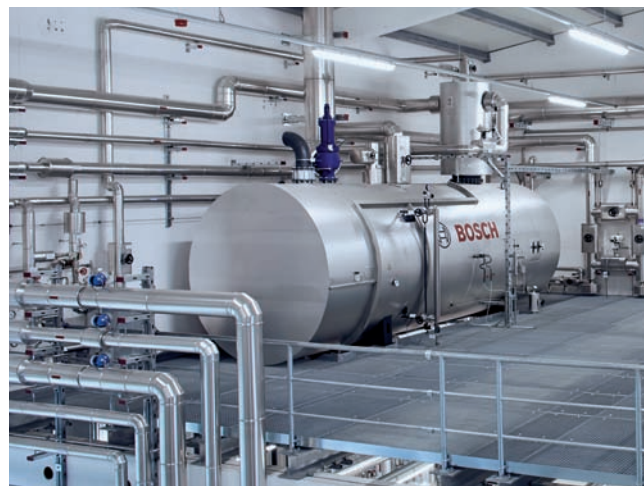
Kotol so špičkovým výkonom je dôležitou súčasťou redundantného usporiadania energetického centra. (© by Endress+Hauser)
