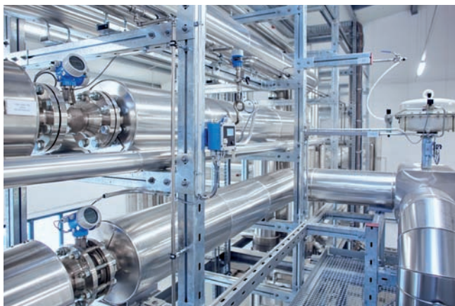
Vírové prietokomery a počítače na meranie pary – pri výrobe mlieka sa používajú rôzne prevádzkové prístroje. (© by Endress+Hauser)
