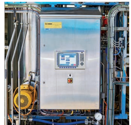
Rozvádzače Rittal Hygienic Design možno umiestniť aj do prevádzok s najprísnejšími požiadavkami na čistotu.
